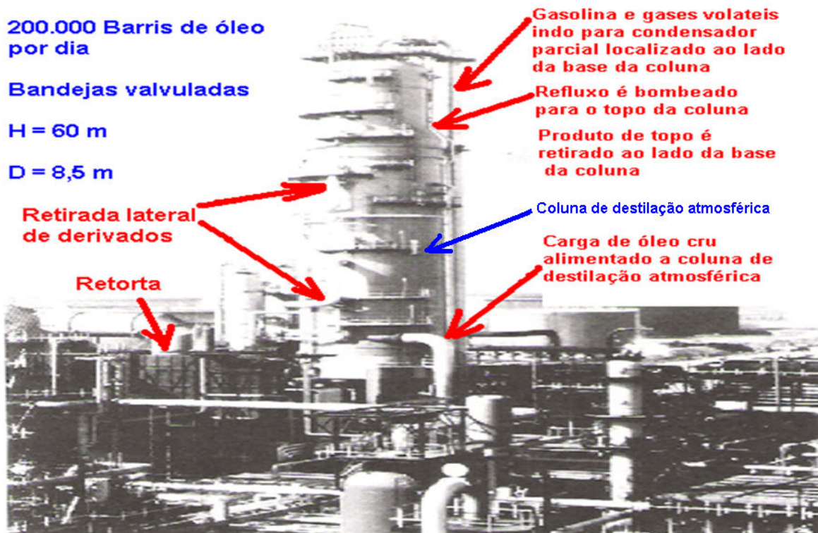
Figura 19 – Coluna de destilação atmosférica.
