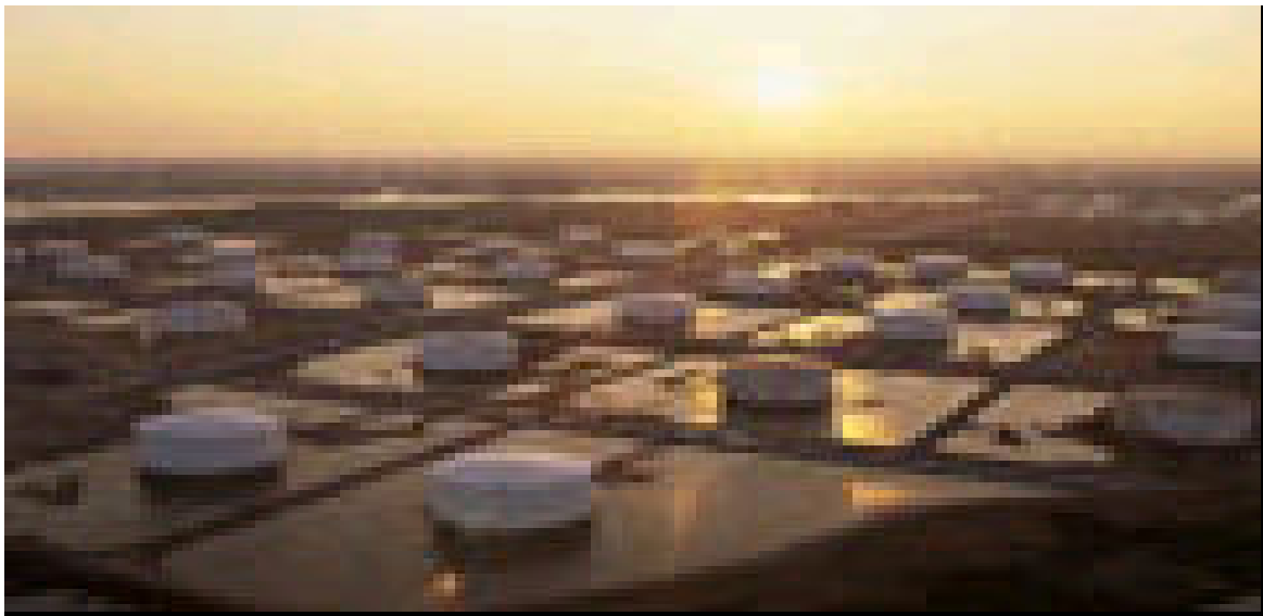
Figura 11 – Tanques de armazenamento de uma refinaria.
